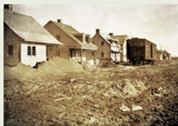
Construction des maisons de la rue Oersted, 1926. / House construction on Oersted street, 1926. Source : Archives de Rio Tinto Alcan, Montréal, Jon/26/2#1
