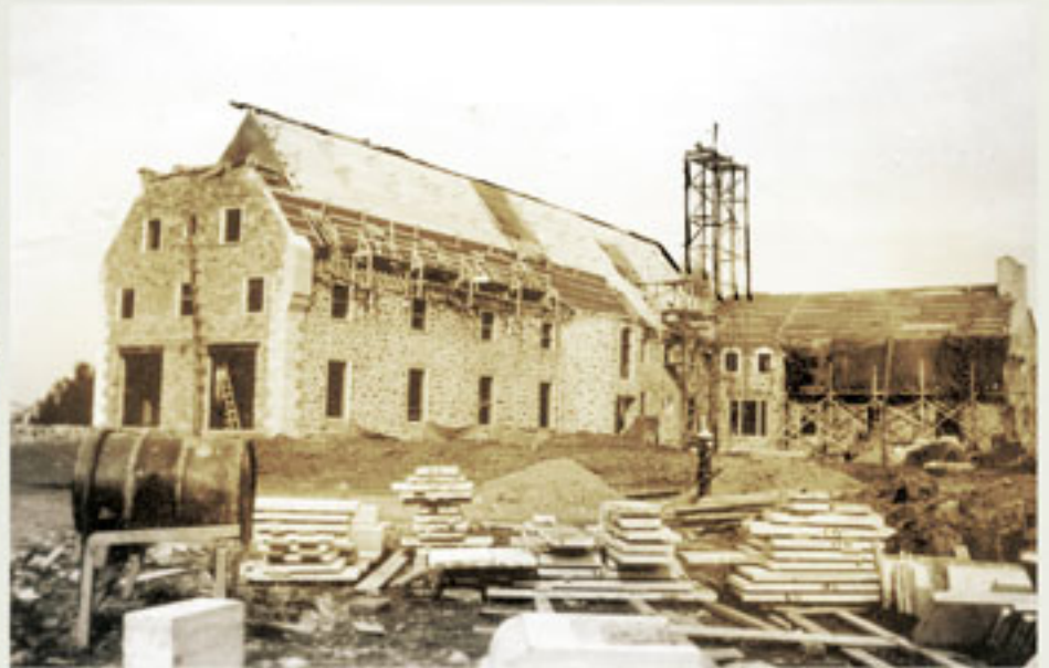
Construction du Manoir du Saguenay (Saguenay Inn), 1939. / Construction of Manoir du Saguenay (Saguenay Inn), 1939. BAnQC-SHS-P2-S7-P00479
