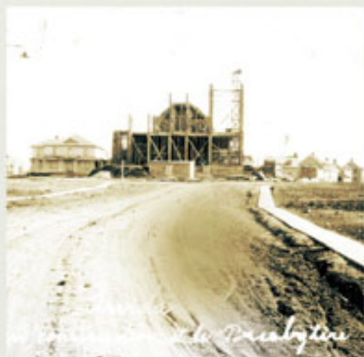
L'église de Sainte-Thérèse en construction en 1928. On aperçoit, à gauche, le premier presbytère. / Sainte Thérèse church under construction in 1928. The first presbytery can be seen on the left. SHS-FPH65-P01167
