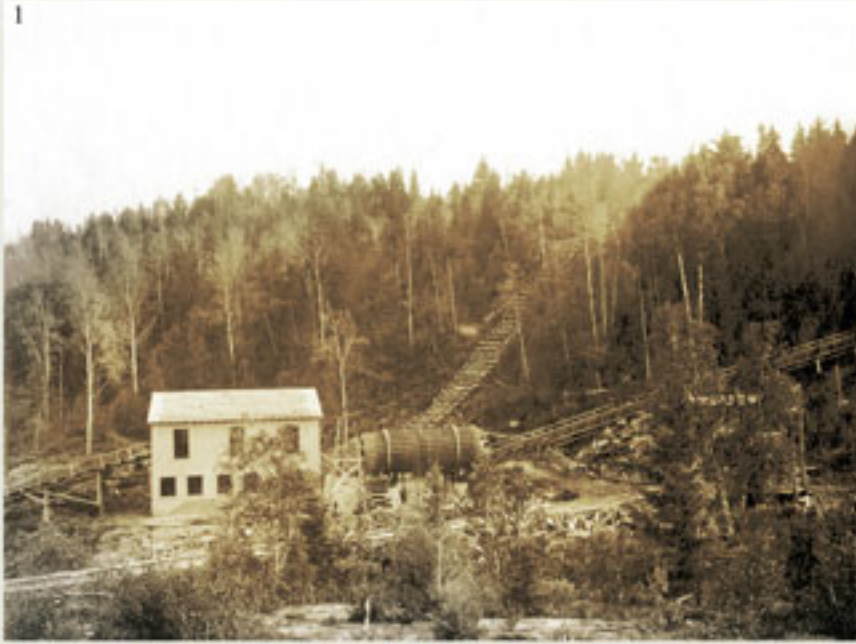
1. Construction d'une conduite acheminant la pâte, par pompage, des meules (sur la rive sud du Saguenay, au pied de la Chute-à-Bézy) jusqu'au moulin. Des vestiges de ce « pâtoduc » s'observent toujours sur le site du parc Price. Construction of a duct intended to carry pulp by pumping from the grinders (on the South shore of the Saguenay River, at the bottom of Chute-à-Bézy) up to the mill. Remnants of this "pulp-duct" can still be seen on the Price Park site. Source : Centre d'histoire Sir William Price / Centre d'histoire Sir William Price, CCHSWP C24/05
