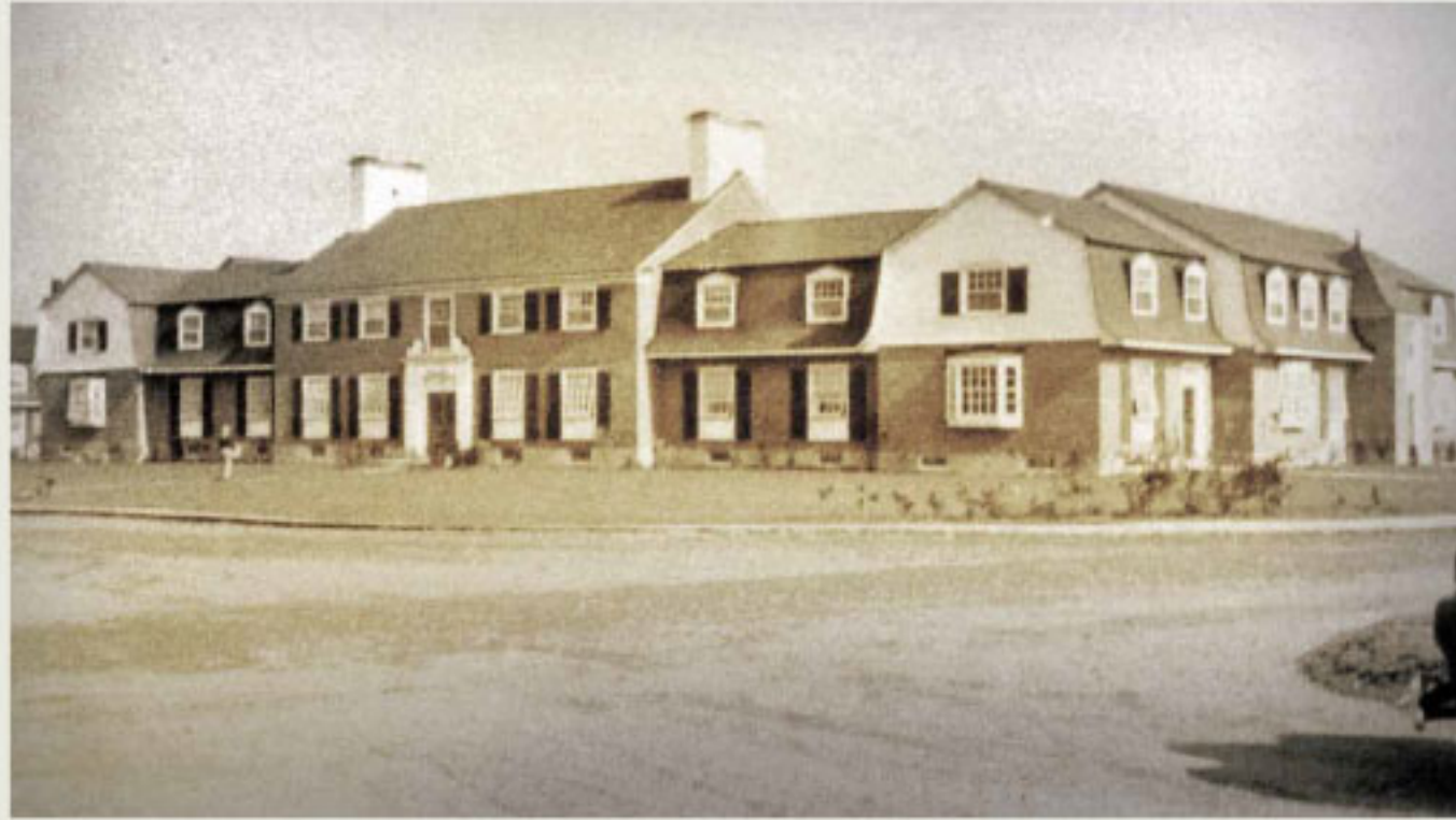
Habitat collectif de type Z, vers 1948 / Type Z collective housing, around 1948 Source : Archives de Rio Tinto Alcan / Rio Tinto Alcan - archives
