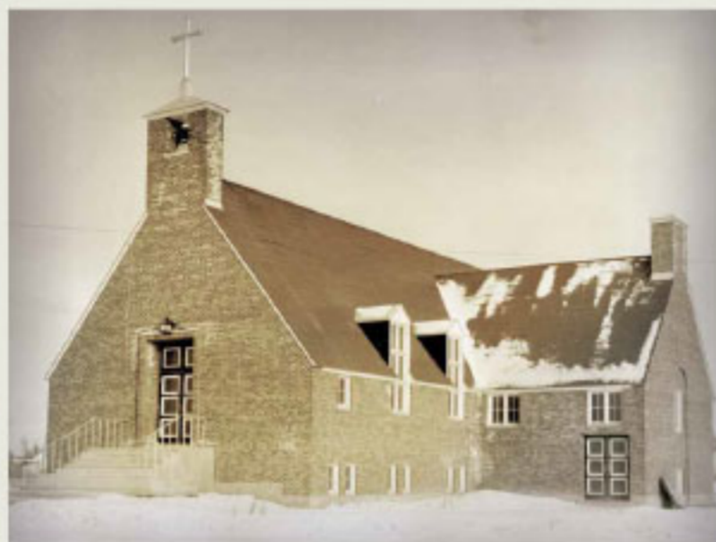
Église anglicane Saint-George-the-Martyr , coin de la 1 re Rue et de Taschereau, Arvida, inaugurée le 17 décembre 1950/ St. George the Martyr Anglican Church of Arvida , situated at the corner of 1 st Street and Taschereau Blvd., inaugurated December 17 th 1950 Source : SHS-P2-S7-P03738-1
