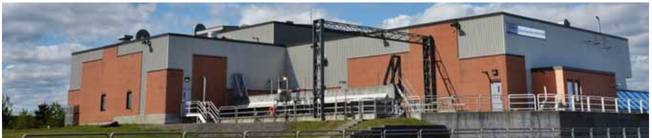
Usine d'épuration des eaux usées dans l'arrondissement de Chicoutimi
