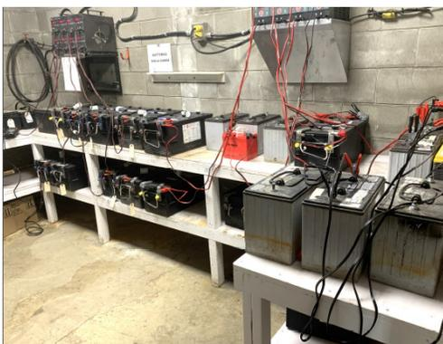
Photo 10 : Batteries branchées sur des chargeurs de batteries intelligents
