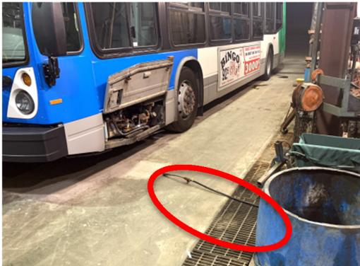
Photo 6 : Des boyaux de remplissage d'huile qui ne se rendent pas aux véhicules
