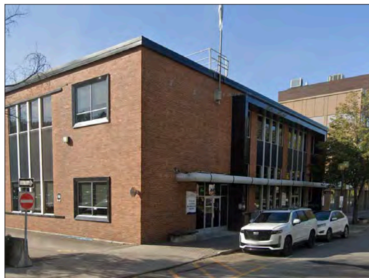
289. Vue de l'angle du bâtiment, 2021 (GoogleMaps)
