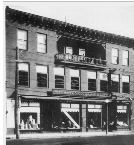
343. Façade du magasin général Gagnon & Frère, reconstruit après l'incendie de 1912, s.d. (Chicoutimi : 150 ans d'images)
