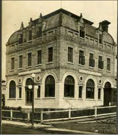
318. Édifice de la Banque Molson lors de son inauguration, 1907 (BAnQ)
