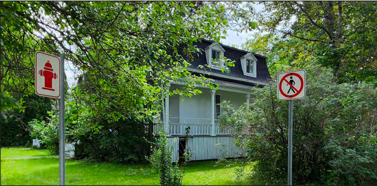
230. Vue de la façade latérale Ouest, 2024
