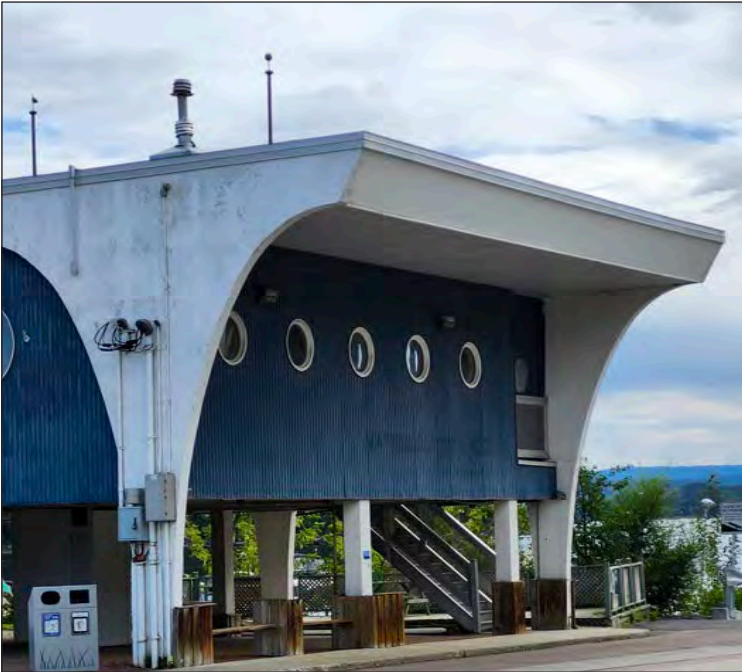
413. Détails de la façade sur la rue, 2024
