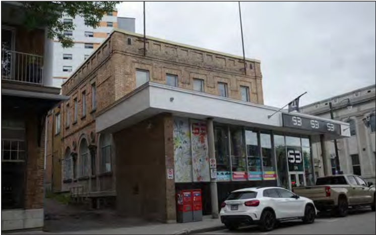
317. Façade latérale avec les fenêtres d’origine, 2024
