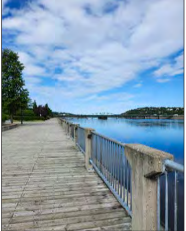
412. Vue de la Promenade publique vers le pont, 2024
