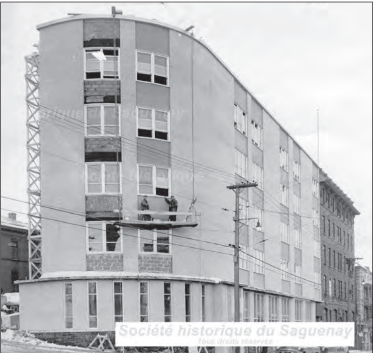
393. Hôtel Chicoutimi en construction, 1960 (Société historique du Saguenay)
