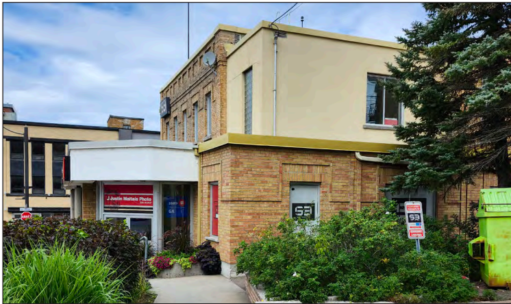
321. Façade arrière montrant des agrandissements, 2024
