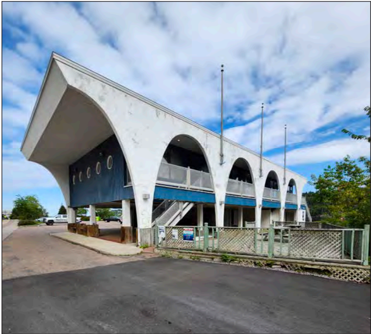
414. Façade latérale vers la rivière Saguenay, 2024
