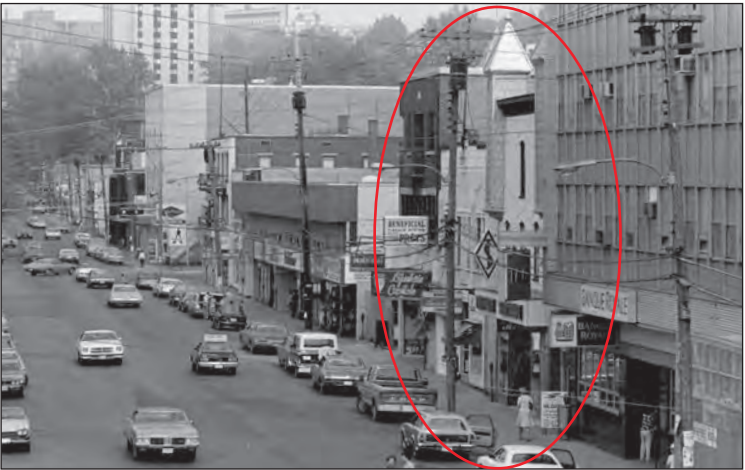
279. Vue de la rue Racine montrant une partie de la façade, 1976 (BA NQ )
