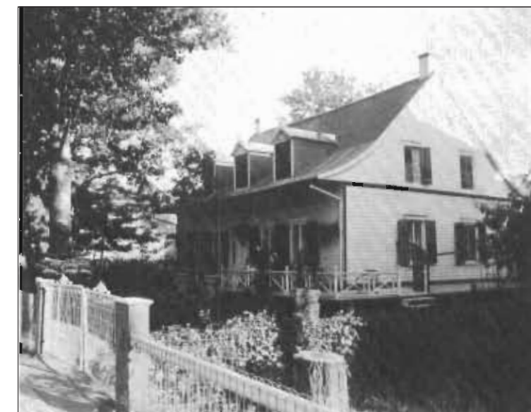
291. La « Vieille Maifon » démolie en 1958, s.d. (dans Nos souvenirs prennent vitrines)
