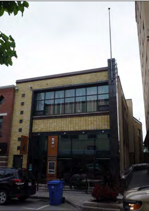
334. Ancienne Banque provinciale du Canada, 2024
