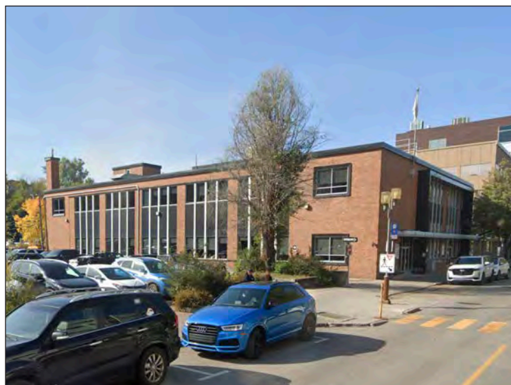
288. Vue façade latérale, 2021 (GoogleMaps)
