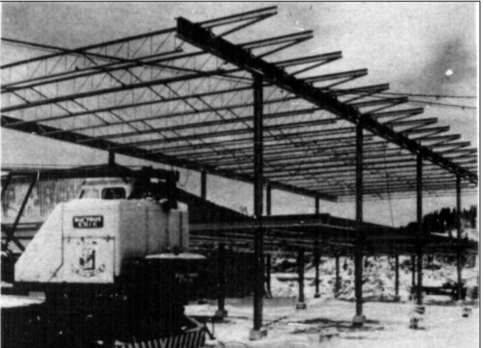
419. Charpente du Club nautique en construction, 8 avril 1965 (Le Lingot : un journal du Saguenay)
