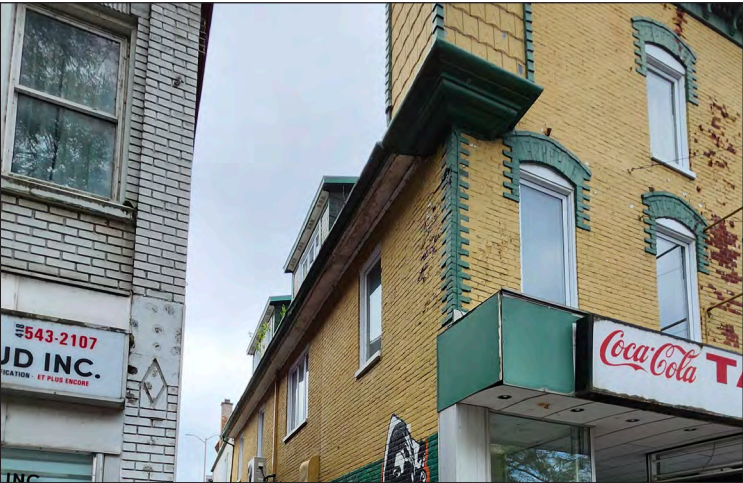
275. Vue des lucarnes sur la façade latérale, 2024
