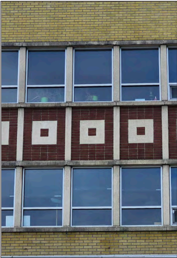
256. Détails de la façade, 2024
