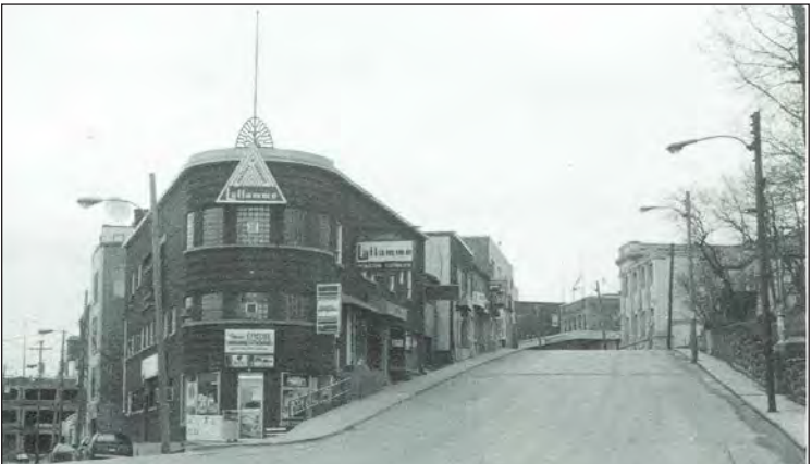
303. Édifice Laflamme, 1991 (Russel Bouchard)
