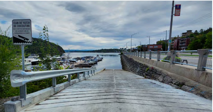
416. Quai de mise à l’eau, 2024
