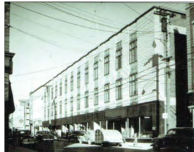
345. Vue du bâtiment, vers 1950 (BAnQ - dans Patrimoines modernes [...])
