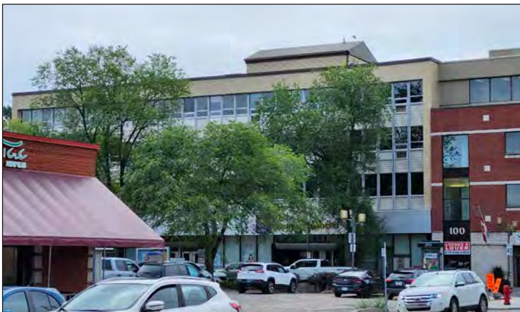
269. Vue de la façade et de l'appentis du toit, 2024
