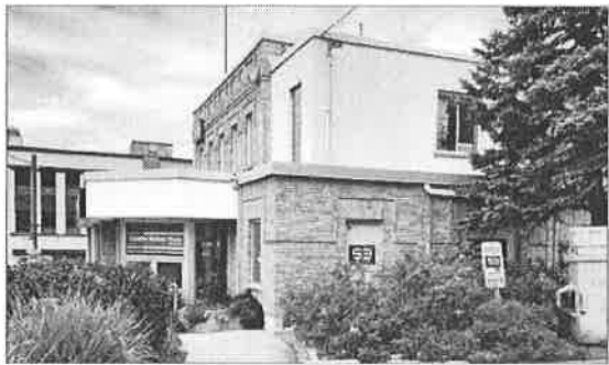
321. Façade arrière montrant des agrandissements, 2024
