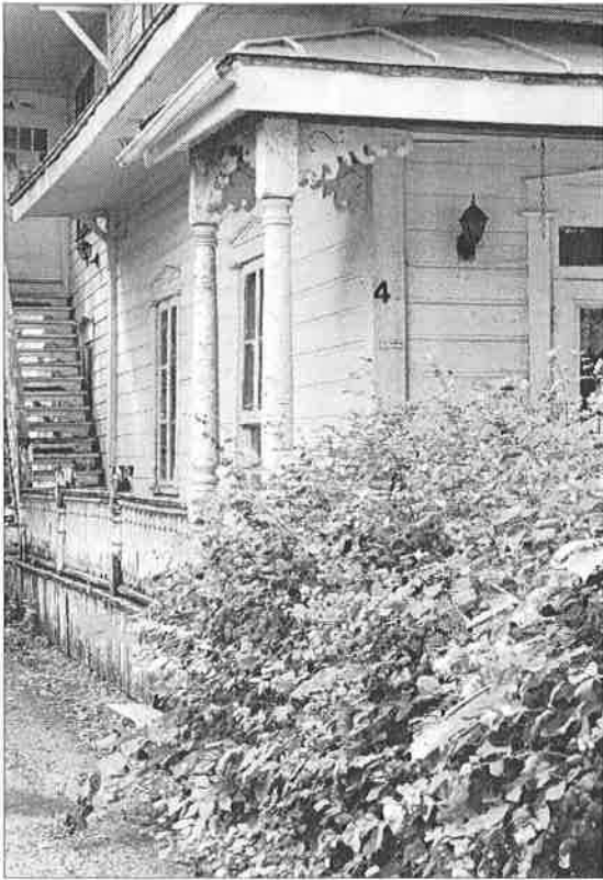
239. État de la galerie, 2024
