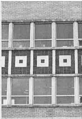
256. Détails de la façade, 2024
