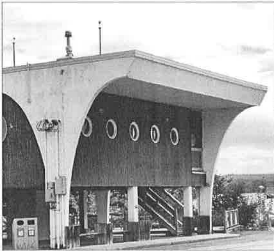
413. Détails de la façade sur la rue, 2024
