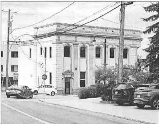
306. Façades arrière et latérale, un agrandissement en brique blanche est visible, 2024
