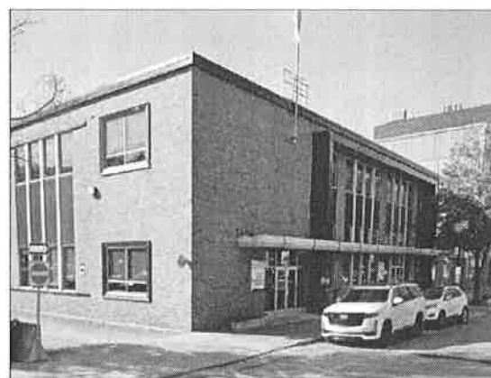
289. Vue de l'angle du bâtiment, 2021 (GoogleMaps)
