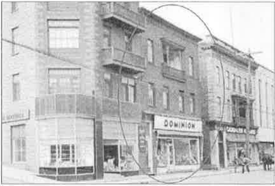
357. Édifice Gilbert & Frères avant l'incendie de 1945, le magasin Dominion occupait le rez-de-chaussée, 1942 (Chicoutimi : 150 ans d'images)
