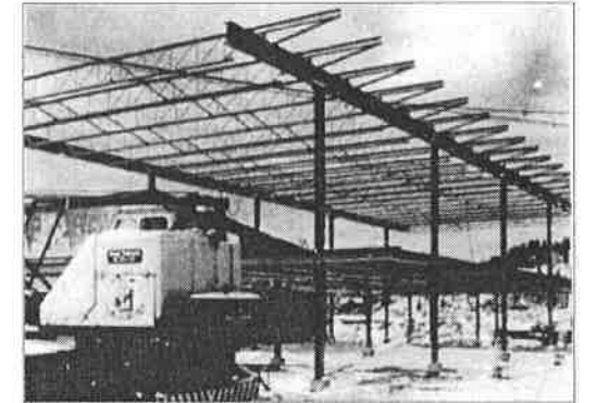
419. Charpente du Club nautique en construction, 8 avril 1965 (Le Lingot : un journal du Saguenay)
