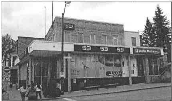
319. Façade latérale de la rue Labrecque, 2024
