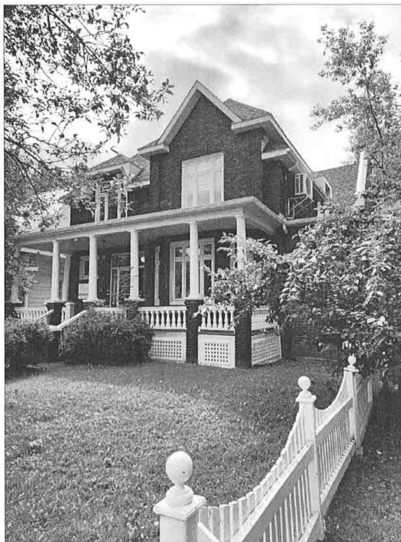
243. Angle des façades avant et latérale, 2024
