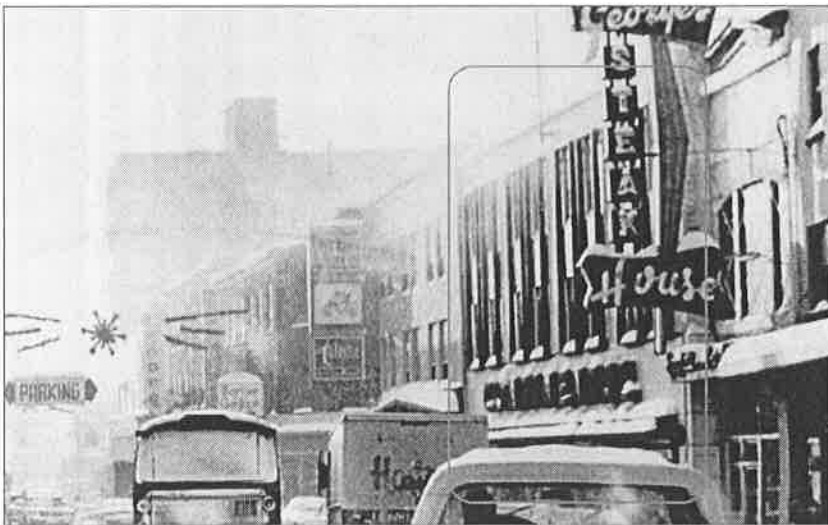
379. Vue de la rue Racine et du bâtiment après transformation, s.d. (Le Quotidien)
