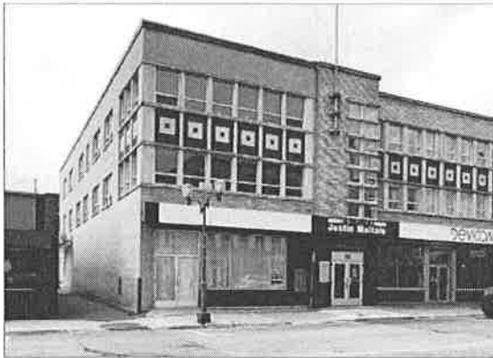
255. Façades latérale et avant de l'édifice Justin-Maltais, 2024
