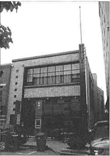
334. Ancienne Banque provinciale du Canada, 2024
