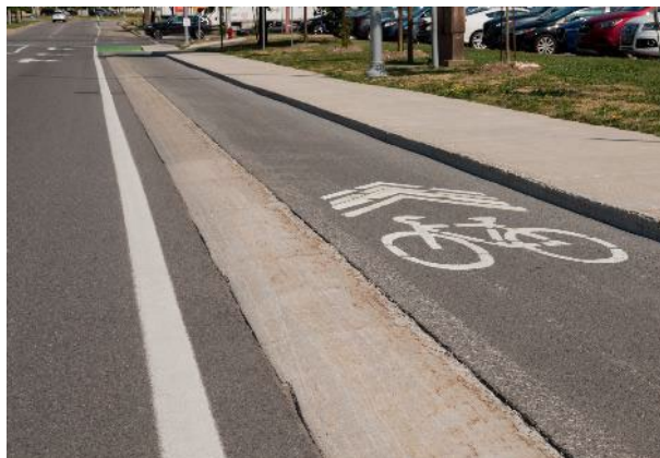
Figure 72 : Surélévation franchissable, boulevard Le Corbusier, Laval
