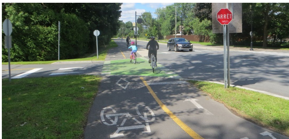
Figure 35 : Revêtement vert antidérapant à Saint-Lambert
