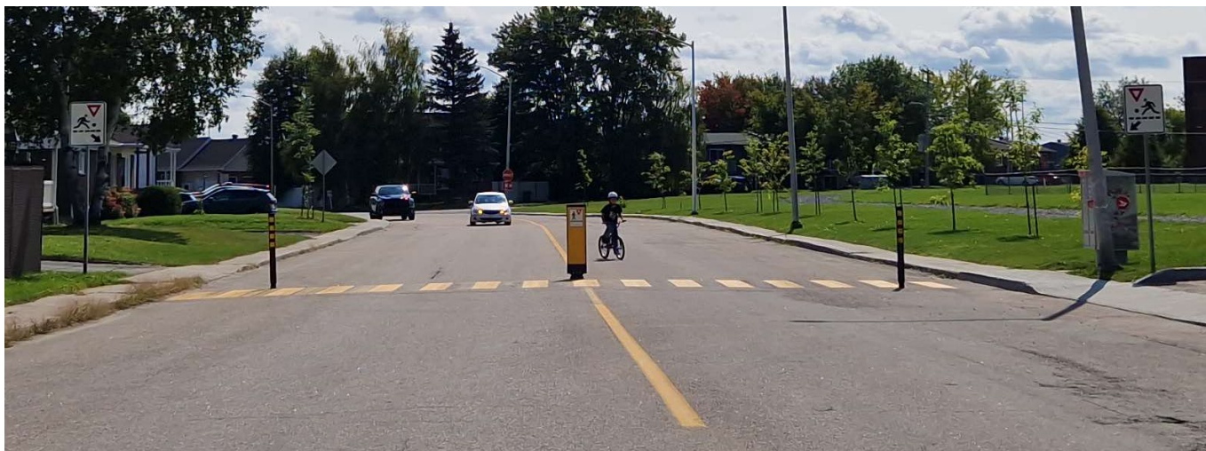
Figure 21 : Passage pour personnes avec balises flexibles et délinéateurs
