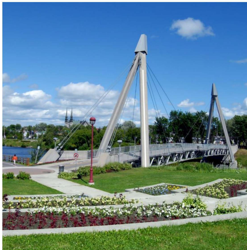
Figure 30. Passerelle de la rivière aux Sables (Crédit photo : Gratien Tremblay)
