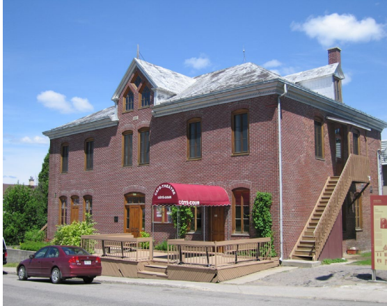
4018, rue de la Fabrique
