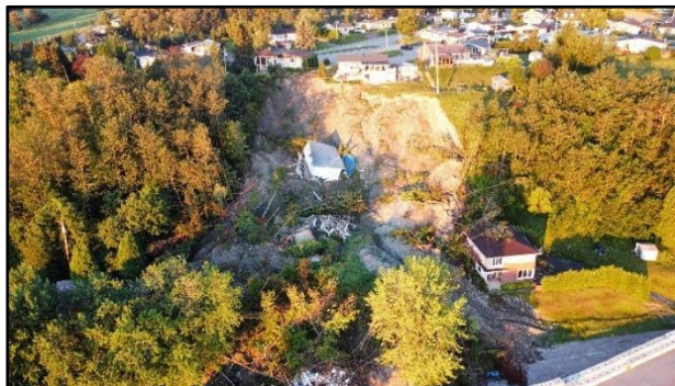
Figure 4. Vue aérienne du glissement de terrain de la 8 e Avenue à La Baie survenu le 13 juin 2022.
